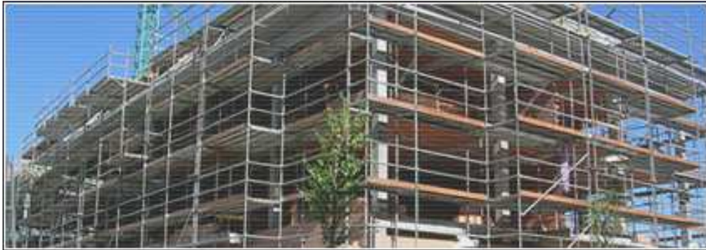
ANDAMIO DOTADO DE MÉNSULA PARA PROTECCIÓN EN CUBIERTA
