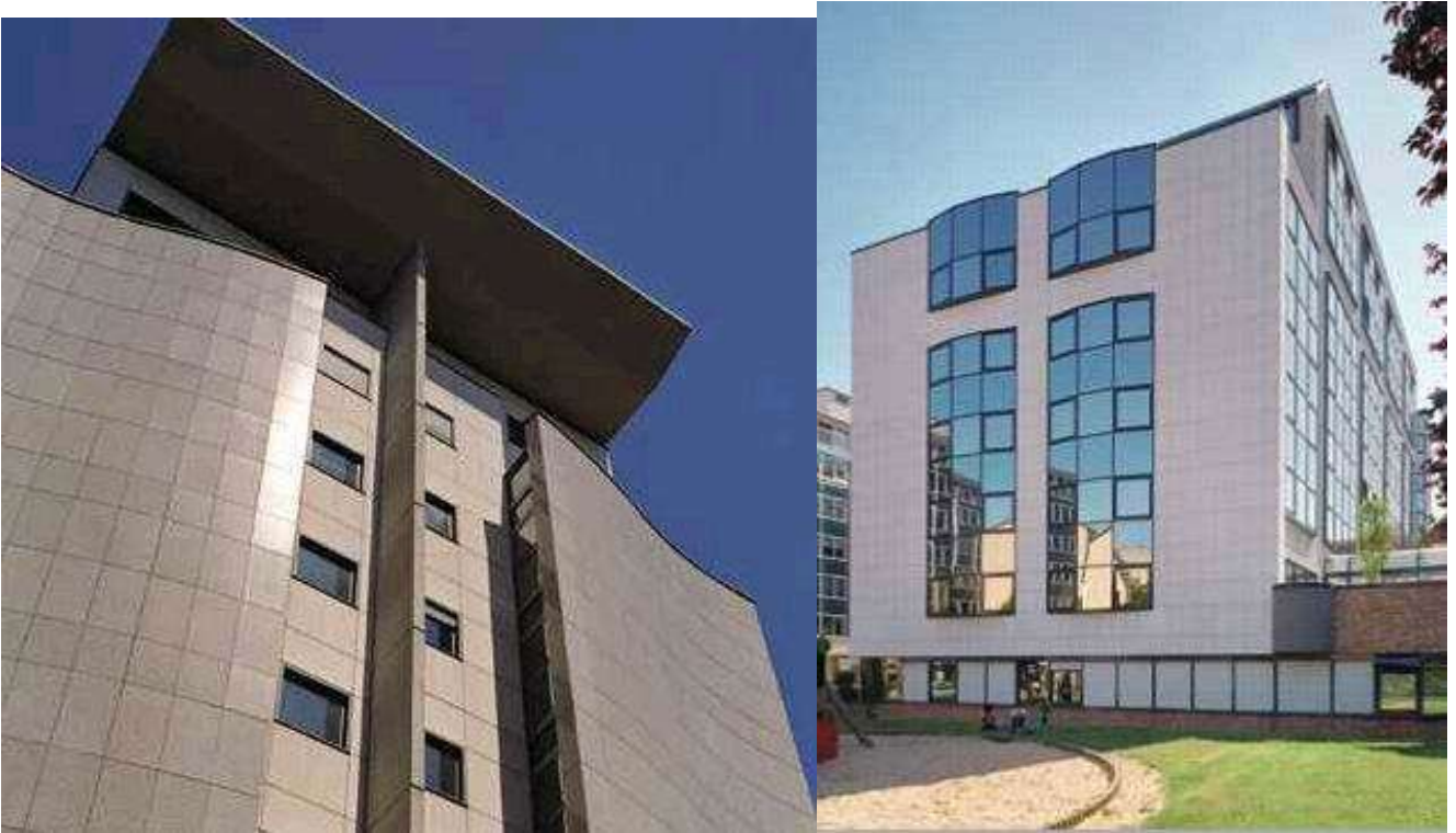
Figura 6.3.4.12 .-Aplacados de piedra natural.
